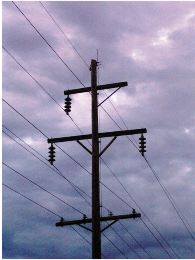
Abb. 2.3 Überlandleitungen auf Holzmasten
