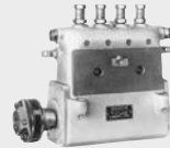
1927 Erste Serien-Reiheneinspritzpumpe
